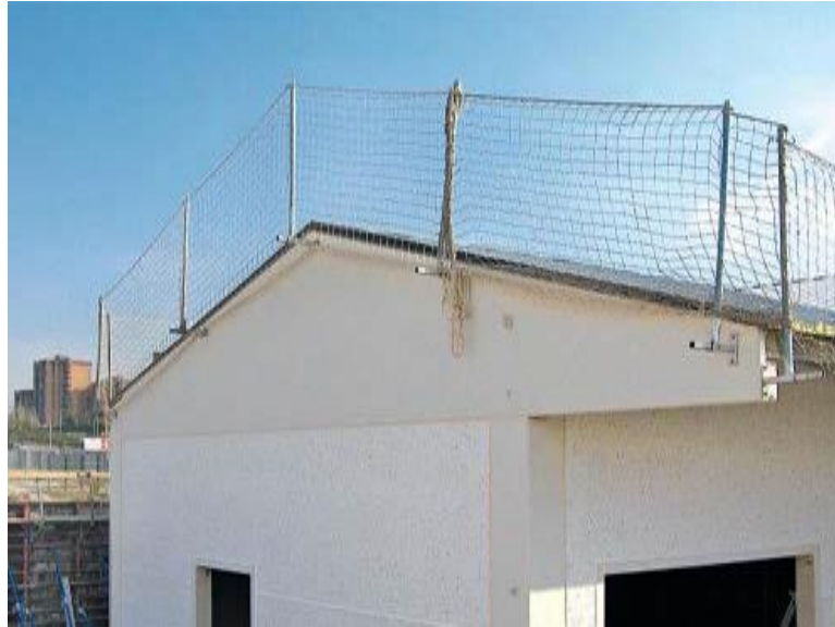
Fig. 5. Redes de seguridad - Tipo U [Fuente: PERI]
