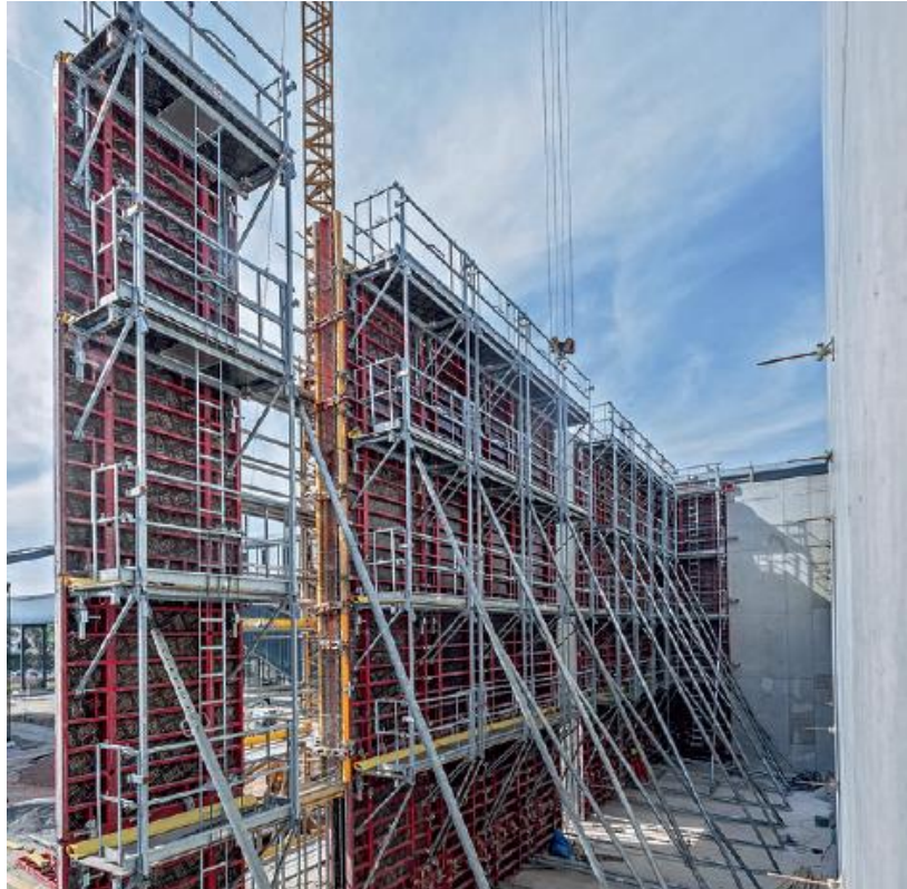
Fig. 3. Barandilla de protección y parte de encofrado ensamblado [Fuente: PERI]
