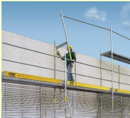
Fig.7 Desmontaje desde el nivel inferior. [Fuente: PERI]
