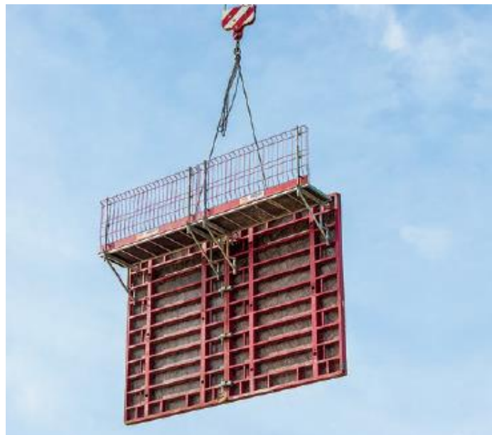
Fig. 4. Transporte de paneles de encofrado ensamblados [Fuente: PERI]
