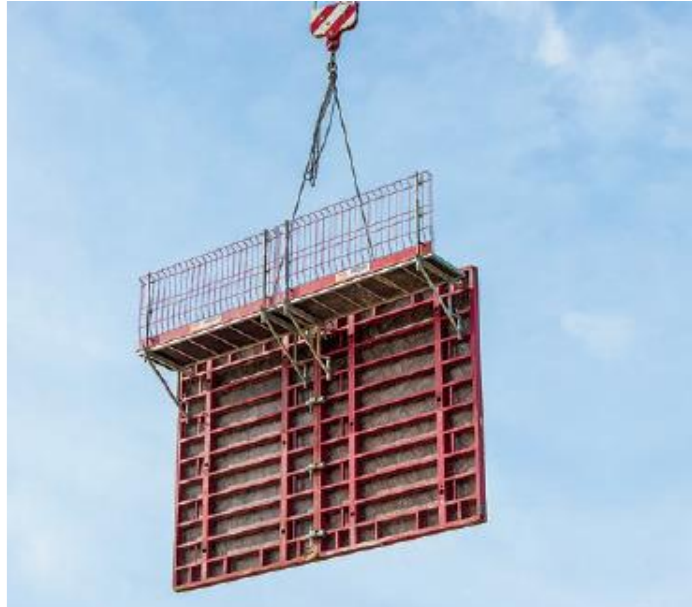
Rys. Montaż deskowania przy użyciu żurawia [Źródło: PERI]
