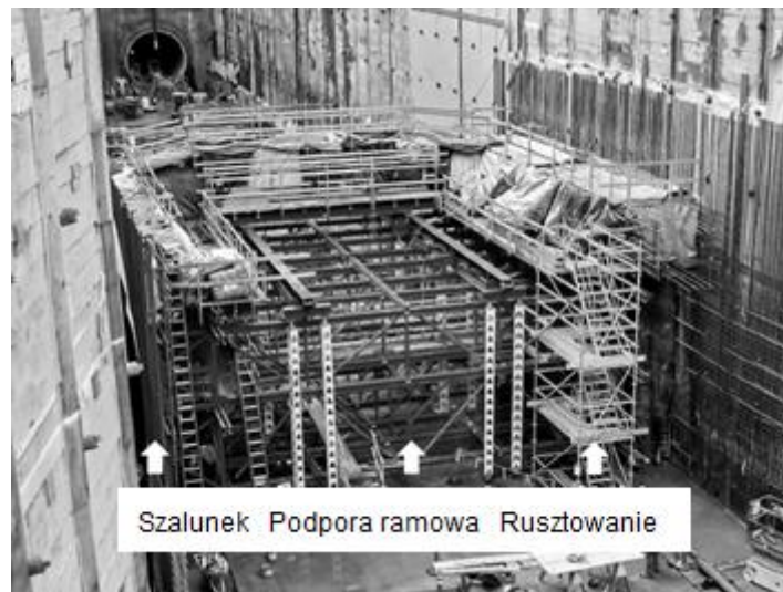
Rys. 2.2.: Rozróżnienie pomiędzy szalunkiem - podporą ramową - rusztowaniem [Źródło: C.Motzko]
