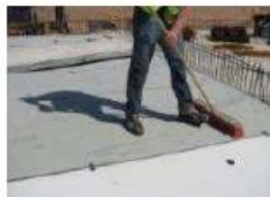
3. Usunąć beton przy pomocy szczotki
