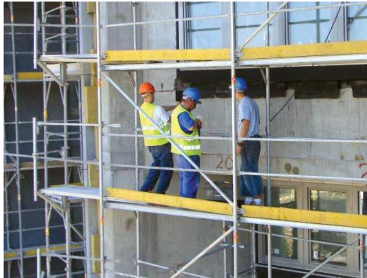
Balustrady rusztowania. [Źródło: PERI]
