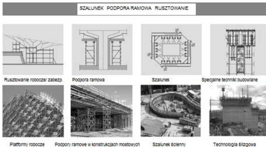
Rys. 2.1.: Szalunki, podpory ramowe, rusztowania - przypadki zastosowań (patrz [1])
