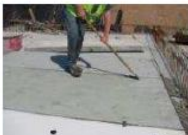
2. Usunąć pozostałości betonu przy pomocy druciaka
