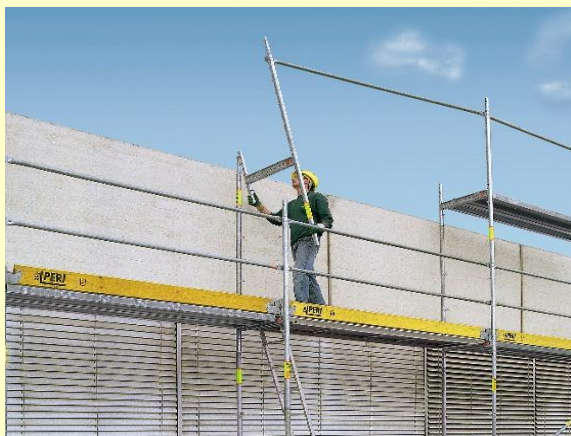
Montaż i demontaż od niższego poziomu - „poręcz przednia”
