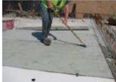
2. Betonreste mit Metallschaber entfernen
