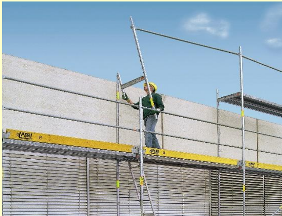
Montage und Demontage von der unteren Etage aus - „Stirngeländer“
