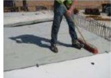
3. Beton mit Besen entfernen
